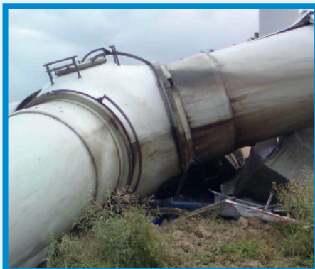
Schäden an der Nabenmechanik mit schlimmen Folgen
